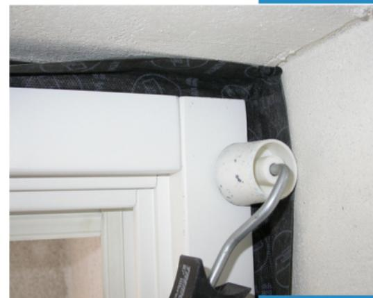
Proponiamo monoblocchi da inserire nella muratura utilizzando tecniche di posa che garantiscono la tenuta all'aria e dell'acqua come richiesto dal Blower Door Test.
